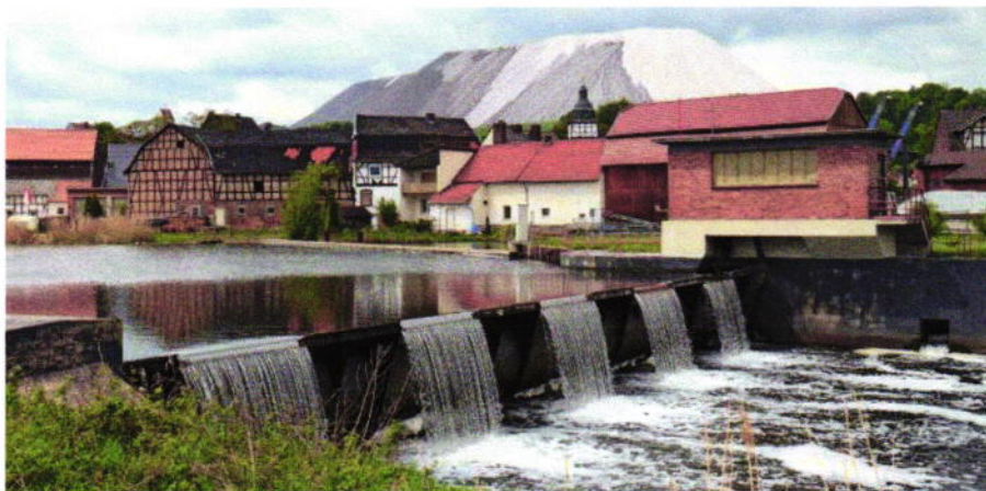
Kali-Salzhalde an der Werra: In 60 Jahren wieder „Süßwasserqualität“
